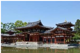
改修なった平等院鳳凰堂
